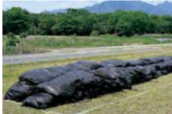
▼作成した土のうを使った「簡易積み土のう工法」
