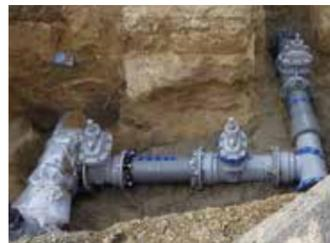
▲既設水道管との連絡部分。既設水道管と接続しながら新たな水道管に更新していきます。
