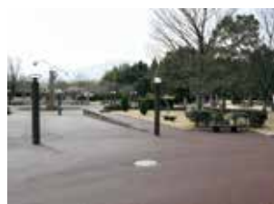
▲福祉公園の舗装改修工事にあわせて設置されました。
