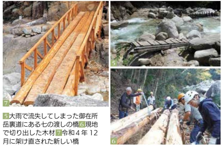
5大雨で流失してしまった御在所岳裏道にある七の渡しの橋6現地ですり出した木材7令和4年12月に架け直された新しい橋
