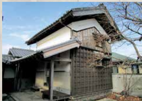
▲貴重な資料の数々が収蔵されていた横山家住宅土蔵の外観
