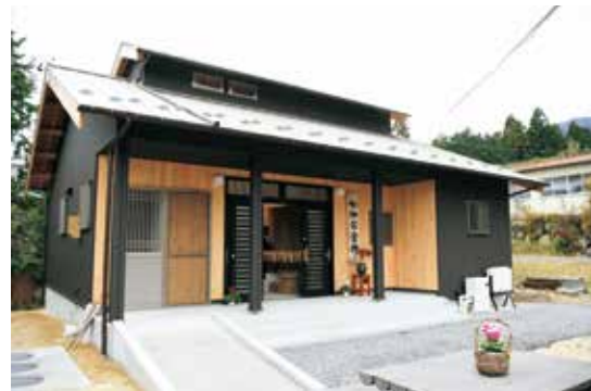
▲竣工された切畑公会所
