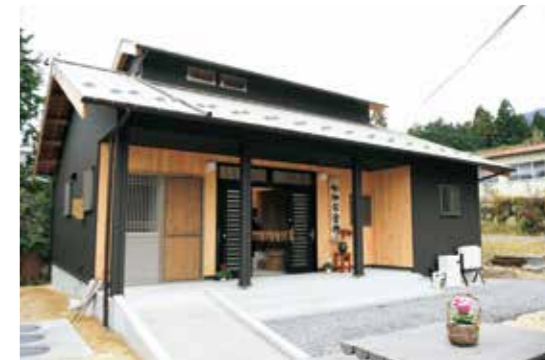
▲竣工された切畑公会所
