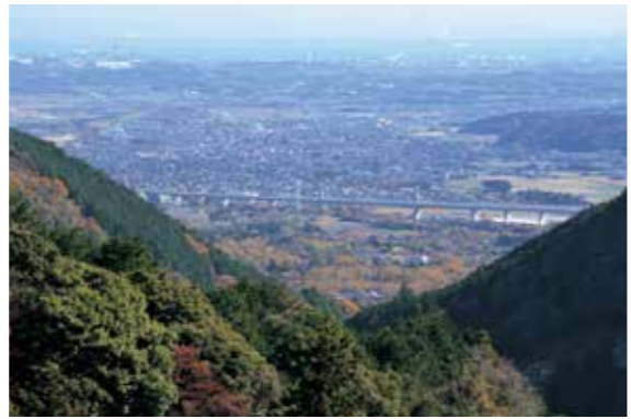
現在建設中の新名神高速道路(湯の山もしか大橋から撮影)
