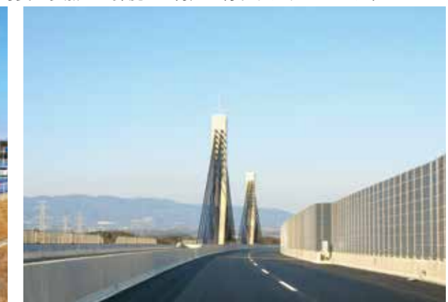
▲三滝川にかかる菰野第二高架橋
