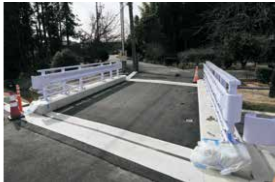
通行が可能となった音羽橋
