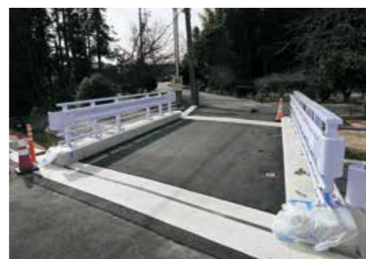
通行が可能となった音羽橋
