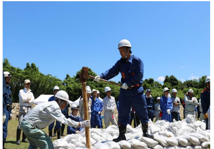
杭打ちの様子
