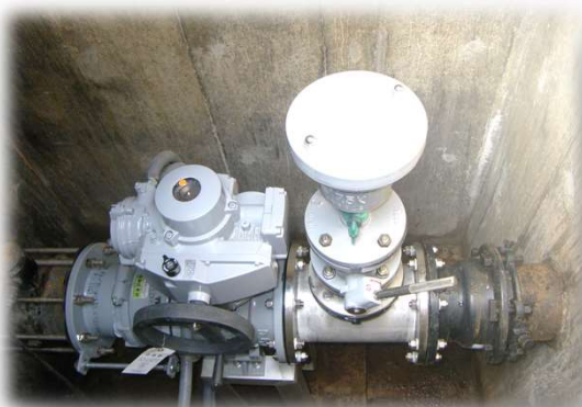
田光配水池緊急遮断弁 H29年(2017年)築造
