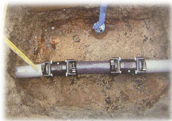
漏水修理状況
