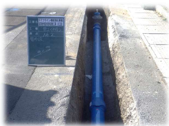
管路更新状況(従来の差込み継手ではなく、耐震性能を備えた融着管等を採用していきます。)
