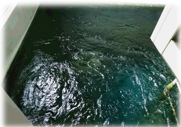
潤田浄水場 着水井 H4年(1992年)築造
