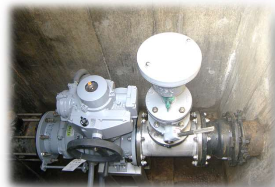
田光配水池緊急遮断弁 H29年(2017年)築造
