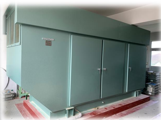
大羽根浄水場自家発電機 S61年(1986年)築造
