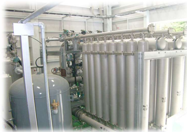
湯の山浄水場膜ろ過装置 H29年(2017年)改修
