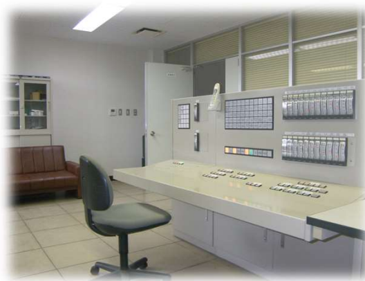
潤田浄水場 管理操作室 H4年(1992年)築造
