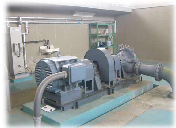
潤田浄水場 送水ポンプ H4年(1992年)築造
