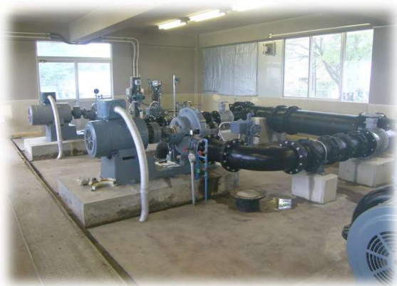
大羽根送水ポンプ S47年(1972年)築造・R2(2020年)改造
