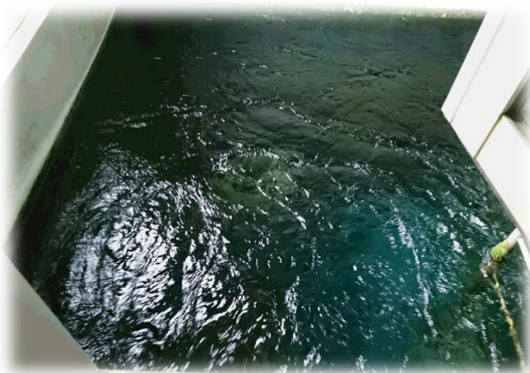
潤田浄水場 着水井 S47年(1992年)築造
