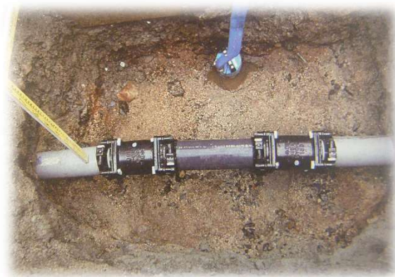
漏水修理状況
