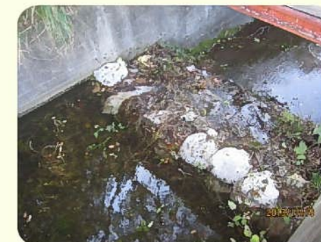
土のうによる洪水吐のかさ上げ
