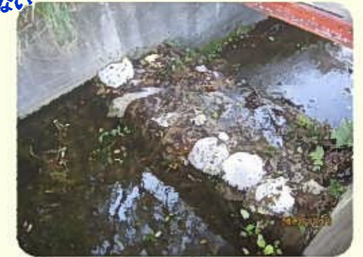
土のうによる洪水吐のかさ上げ
