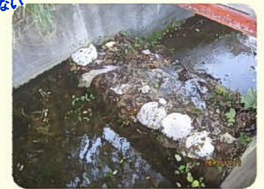
土のうによる洪水吐のかさ上げ
