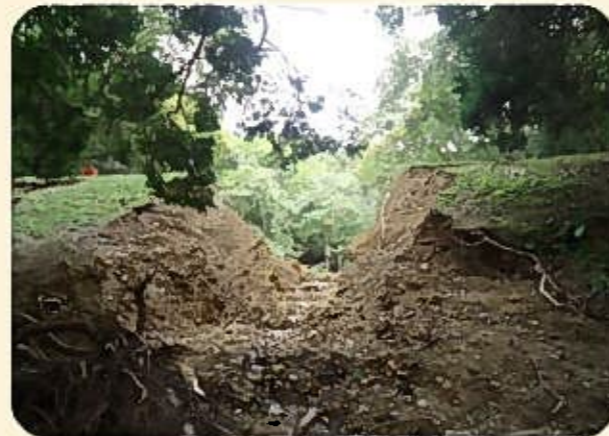
平成25年9月、台風18号による大雨により決壊したため池
